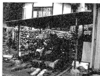
写真-2 上尾崎地区の水屋 (写真は全て筆者撮影)
