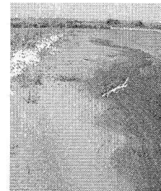
写真-1 水制背後の砂の堆積状況の変化
