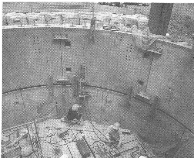
写真-1 セグメントリングジャッキアップ状況
