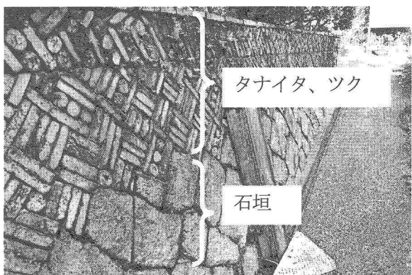
図-4 タナイタ、ツクを組み合わせた窯垣の例
