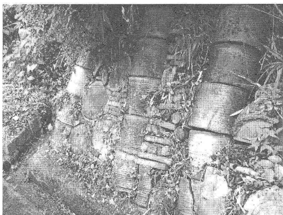
図-3 エンゴロを縦に積んだ窯垣の例
