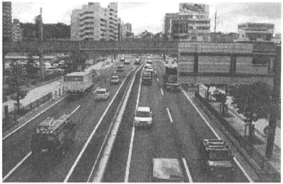
写真一 施工箇所の外観
