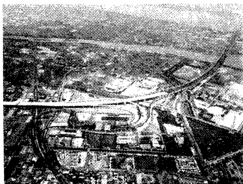
写真-1 完成写真
