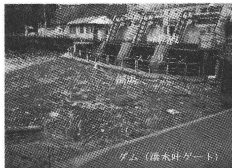
写真-1 水力発電所取水口網場
