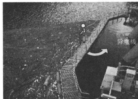
写真-2 網場における塵芥除去作業
