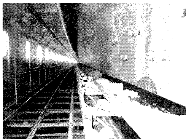
写真-4.1 連続ベルトコンベア稼動状況
