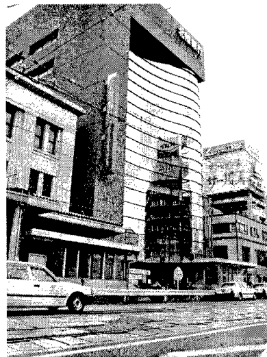
写真-2 現在の様子
