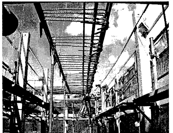
図-5 配力ユニット工法
