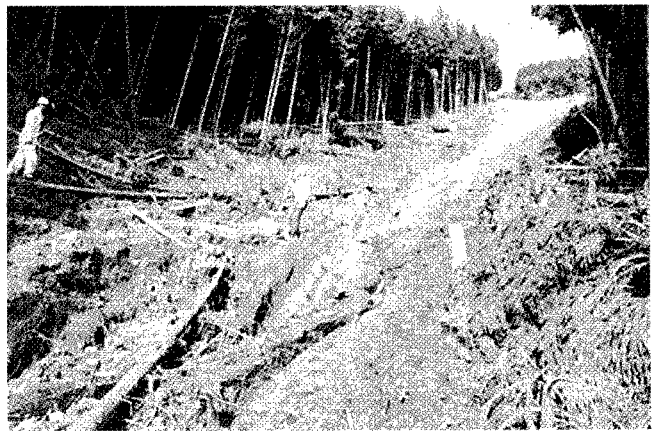
写真－3 上矢作町阿寺の斜面崩壊
