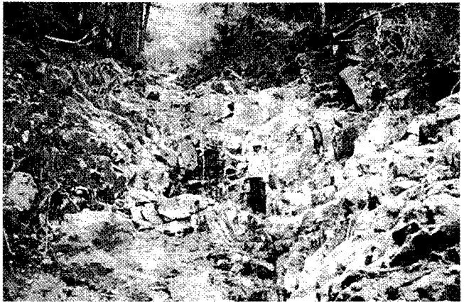
写真－2 国道 418 号沿いの沢ぬけ
