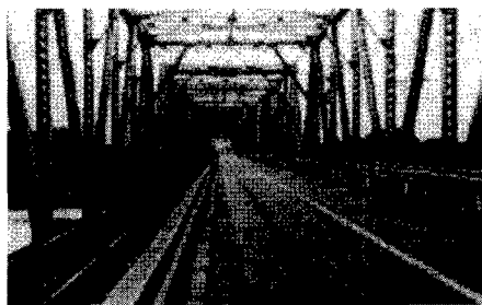
写真-4. 村山橋の様子
