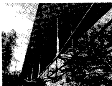
写真-2 吊ケーブルおよび鉛直材の配置状況
