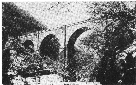
写真1 碓氷第三橋梁
