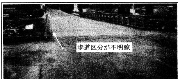
写真-1 車道2車線、歩道区分不明瞭（幅員が狭い）
