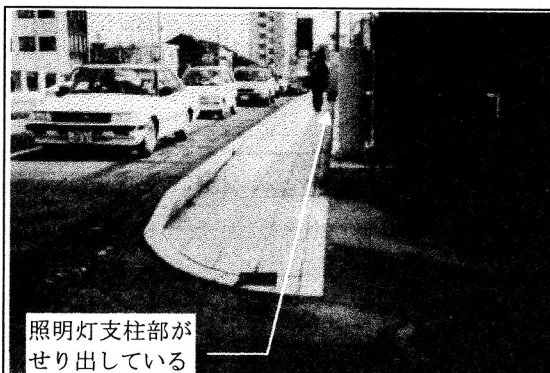
写真-3 歩道幅員への配慮（幅員のあり方）
