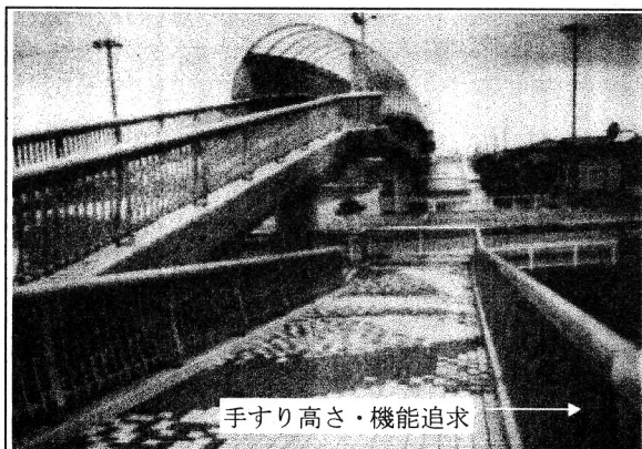
写真-5 歩道橋で折り返しスロープの例（手すり機能）
