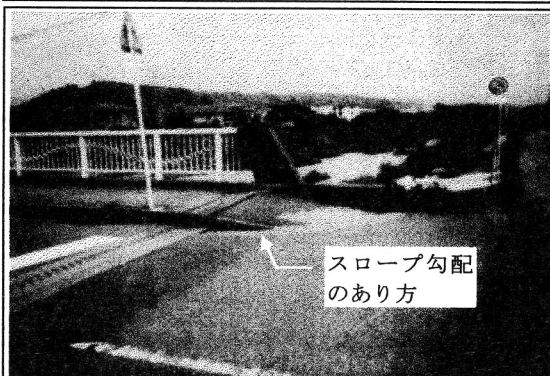
写真-4 アプローチ部との接続（スロープのあり方）
