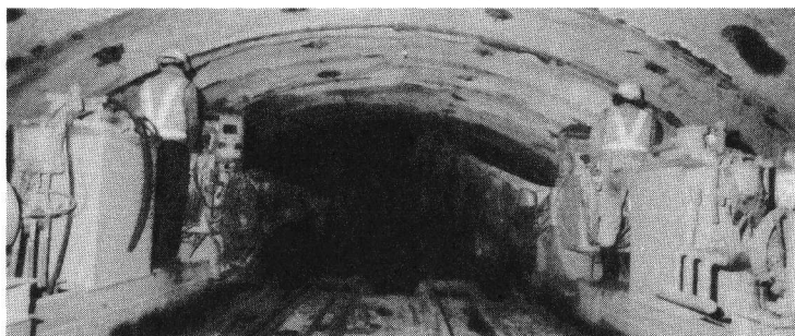
写真 1 ジャンボ上段での削孔状況
