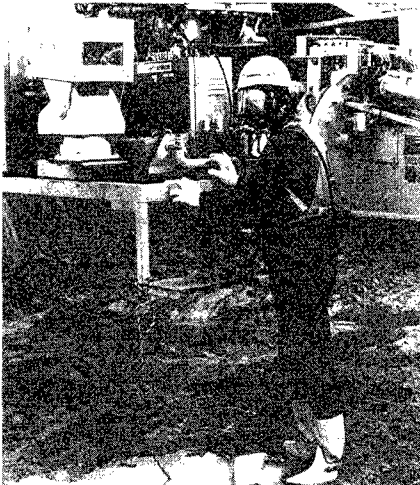
ヘリウム混合ガス呼吸での函内無人掘削機のメンテナンス
