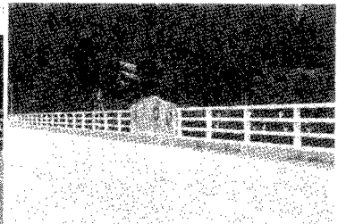
写真-3 斜め方向高欄（斜め）
