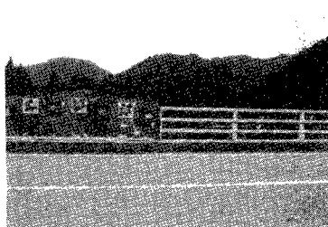
写真-2 正面方向高欄（正面）
