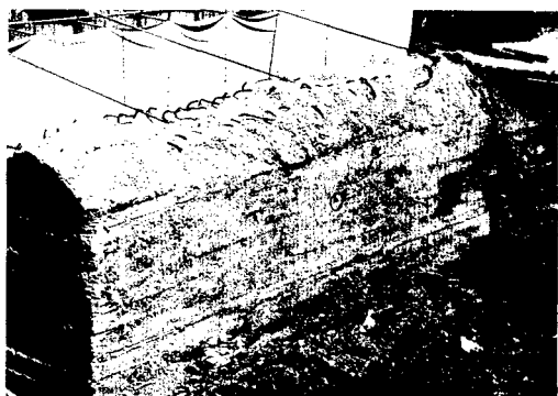
写真-1 橋台部のコンクリート
