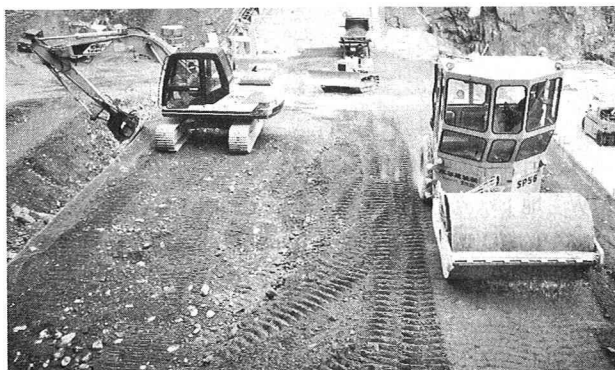
写真-1 転圧状況（8 t級振動ローラ）
