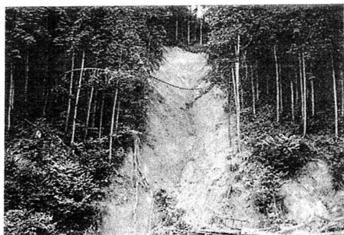
写真-1 V字型斜面崩壊の例
