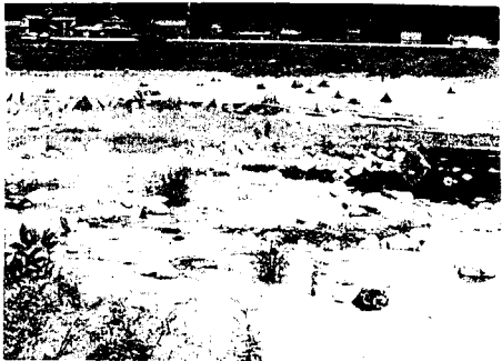
図-1 人工ブロックの流出状況（長良川支流）
