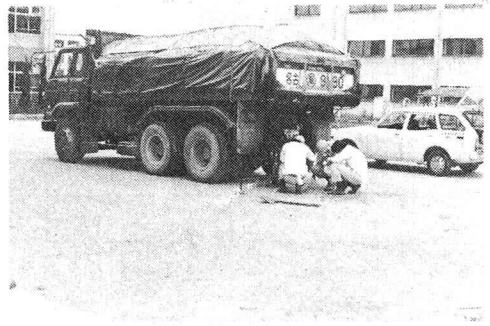
写真-1 路床土の支持力調査の状況
