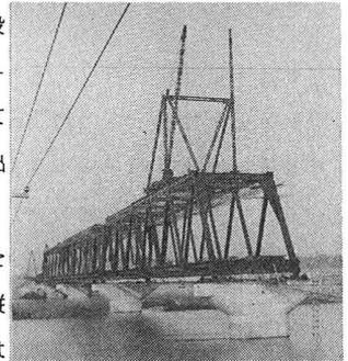
、3パネルまでは複線用鋼製バンド3基（貸与）を建込み、前記トラッククレーンにより組立架設し以降は架橋クレーンによるね出し架設とした。No9連目（WTT862-12）特殊桁については重量820tと標準桁より約60tも重いので、4格点目を鋼基礎杭上に鋼製バンドを建込み仮受けする結果となつた。一連の架設所要日数は15～20日間を要したが、台風シーズンに工程を左右されるような大型のものに遭遇せず計画通り進めることができた。
