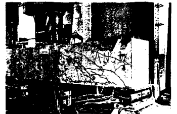
写真-1 供試体ひび割れ状況
