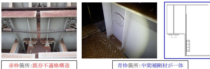
図-1 主桁切欠き詳細
