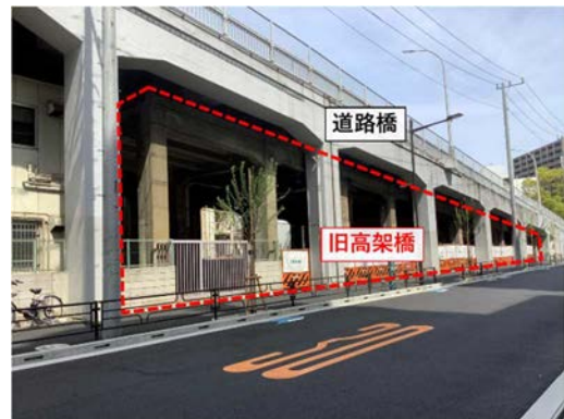
図-2 現場状況写真
