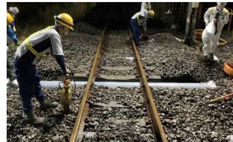
写真-1 軌道横断管路施工状況
