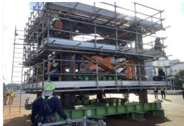
写真-3 降下設備 試験施工
