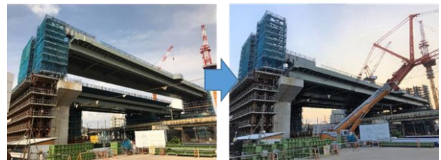
写真-4 桁降下前後
