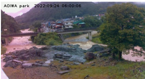
図-6 青岩公園(群馬県下仁田町)における台風後の撮影画像(2022年9月24日6時00分)
