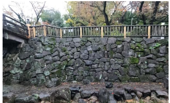
図-1 対象構造物の石積み擁壁
