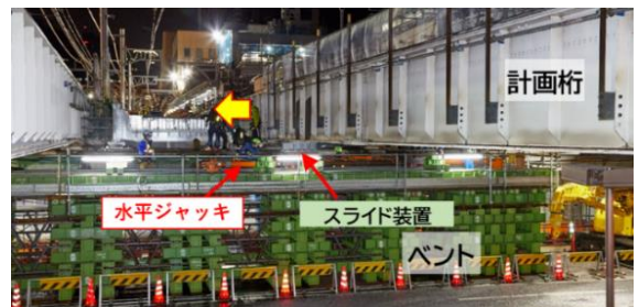
図-5 桁移動回転設備写真
