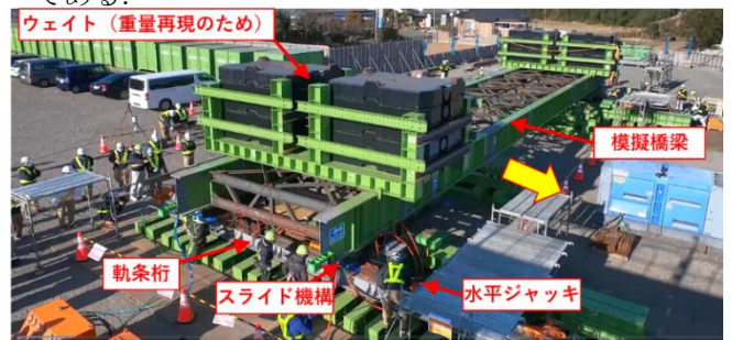
図-4 試験施工写真
