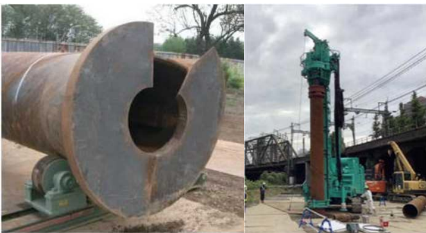
写真-1 回転圧入鋼管杭
