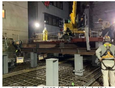
写真3 仮設構台 (改良後)
