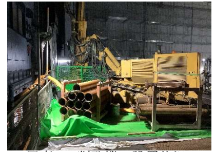
写真4 削孔機の設置状況
