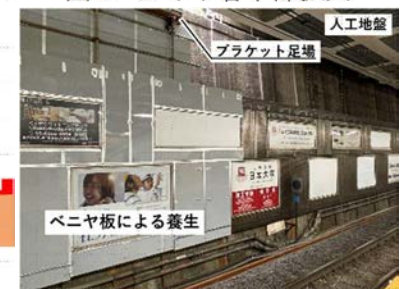
写真5 壁面養生状況
