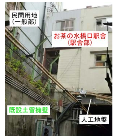
写真-1 お茶の水橋口駅舎部
