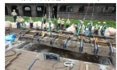
(図-3) 吊上げ試験の様子
