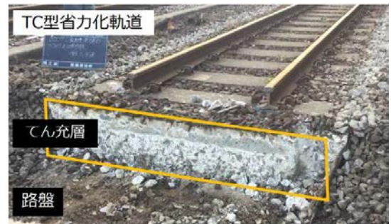
(図-1) TC型省力化軌道断面
