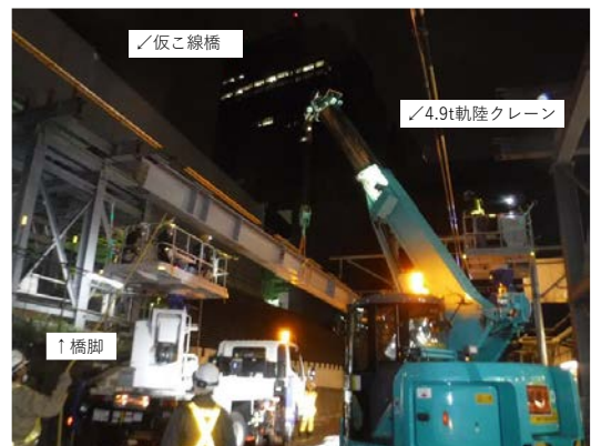
写真-2 主桁撤去状況
