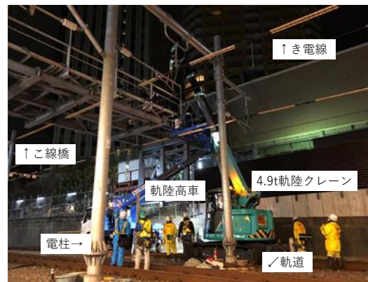
写真-1 軌陸車配置状況例
