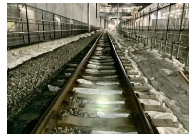
写真1. 事前作業(バラスト袋詰め)
