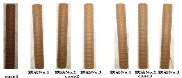
図-3 鉄筋の腐食状況
