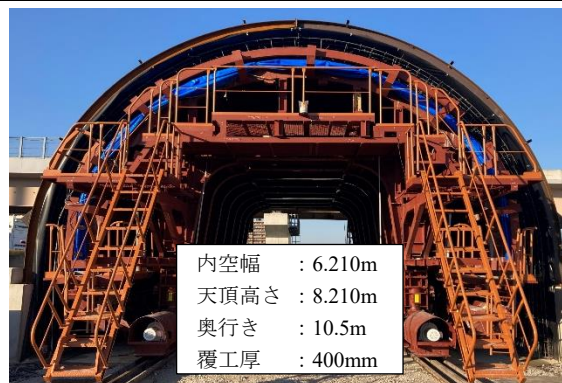
写真-1 覆工実物大実験装置設置状況
