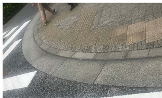
写真3 セミフラット歩道の一例(東京都千代田区神田駿河台付近)
