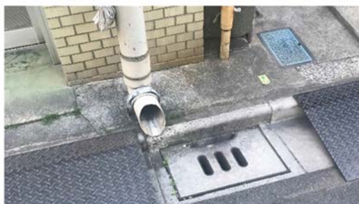
写真2 屋根から道路への直接排水の一例（東京都台東区台東1丁目付近）
