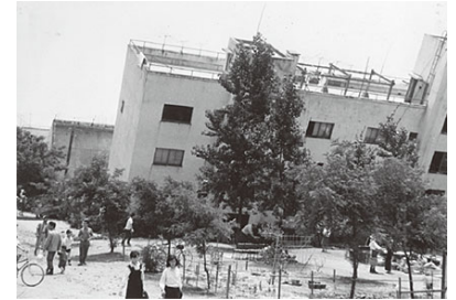
写真-1. アパートの傾倒
