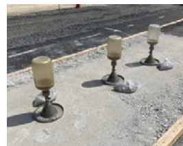
現場密度測定(砂置換法)
