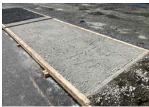
敷均し後状況
