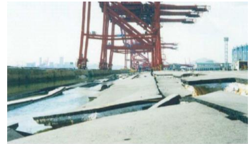
写真-1 岸壁背後地盤の液状化被害
