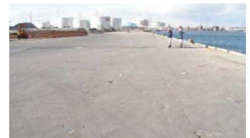
写真-2 薬液注入工法により改良済地盤
