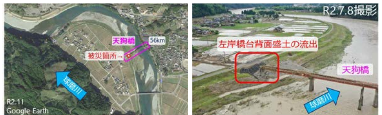
(a) 被災した天狗橋(56km) (b) 左岸橋台背面盛土の被災状況 図-1 令和2年7月球磨川洪水による天狗橋(56km)の被災状況
