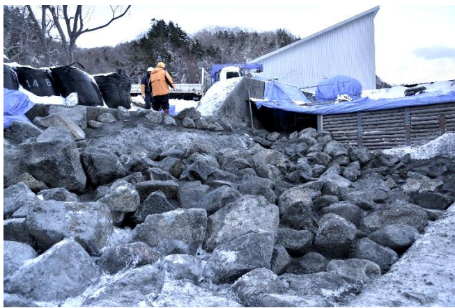
写真 5 石組み魚道施工完了時の状態
