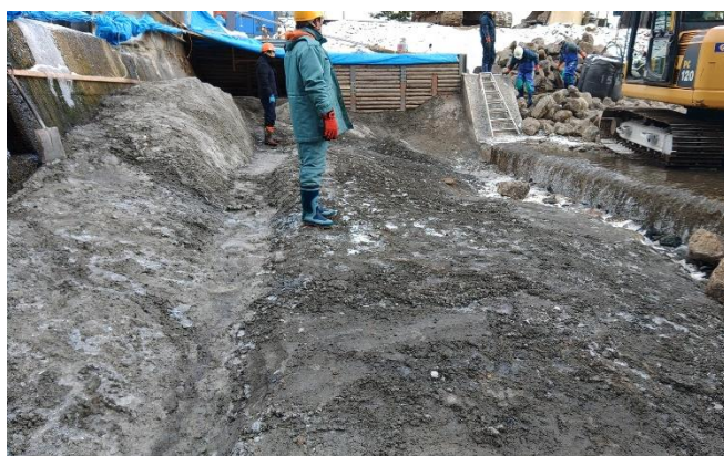
写真 3 コンクリート打設した土台の状態
