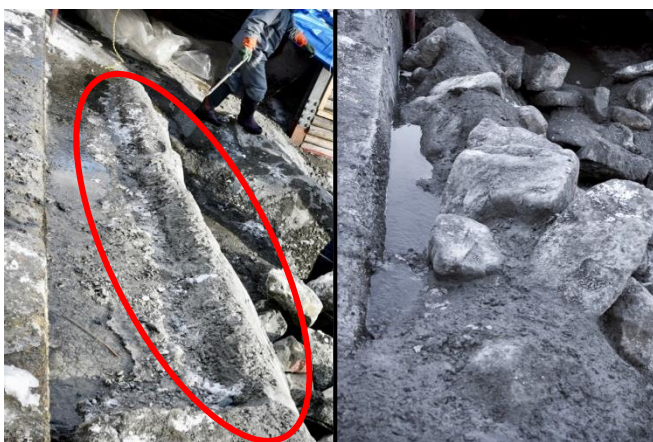
写真 4 切り欠き部直下の土台と石組みの状態 (赤囲み:土台に設置したマウント部分)
