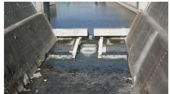
写真2 分水堰に設置された魚道
