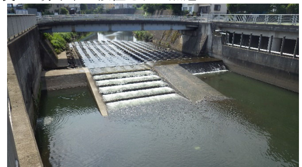
写真3 分水調整池上流側に整備された魚道
