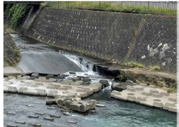
写真1 帷子川と中堀川との合流点の落差部
