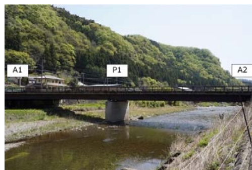
図 2 A 橋の全景
