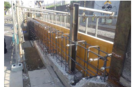
(a) 内部配筋の様子
