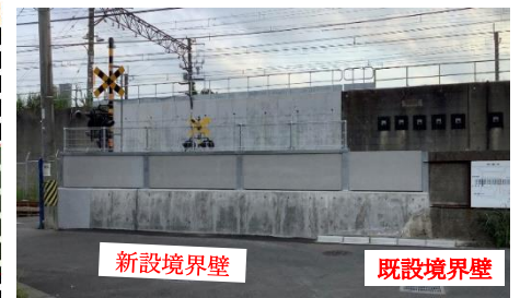
(b) 擁壁構築後
