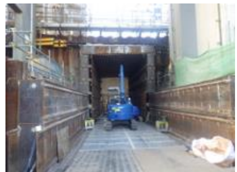
図-7 函体内部掘削後の状況
